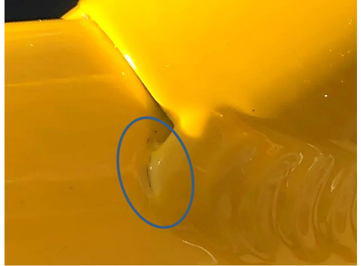
Microfissure longeant le cordon de soudure
